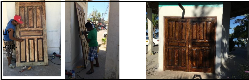
Reparación de puertas
