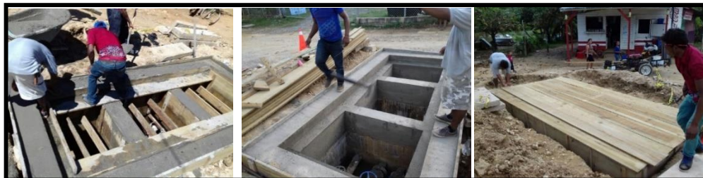
Paredes fundidas y colocación de madera sobre superficie, evitar accidentes
