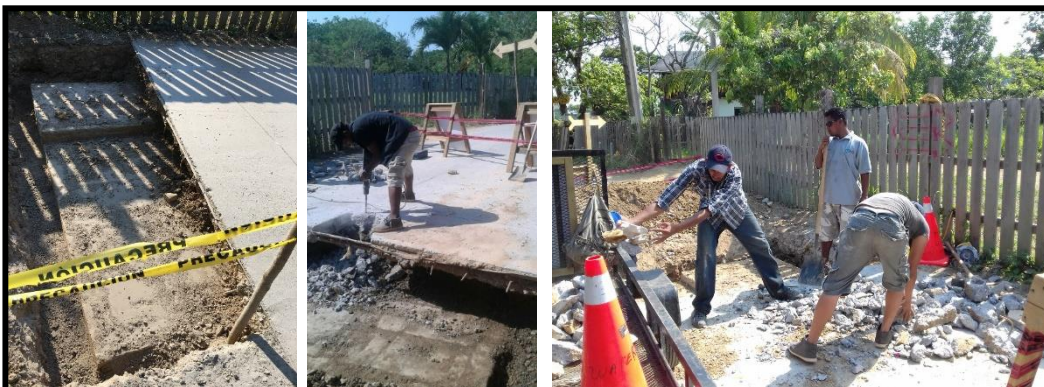
Retirando y botando el concreto del corte de pavimento
