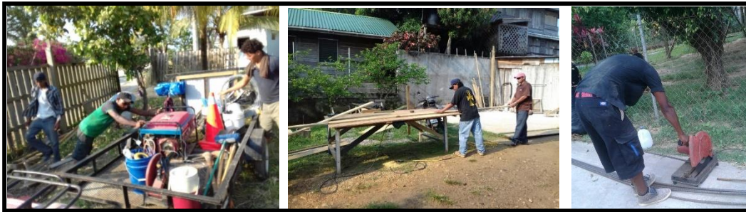
Preparación de materiales necesarios para ejecución de obra.
