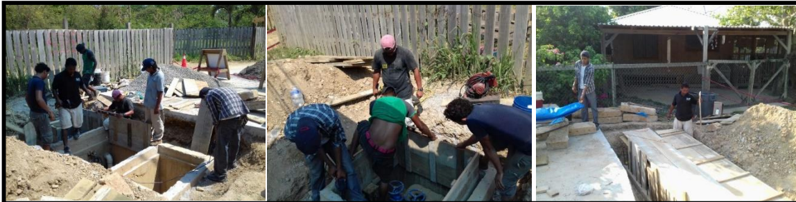
Encofrando y sellado con madera al finalizar las actividades para evitar accidentes
