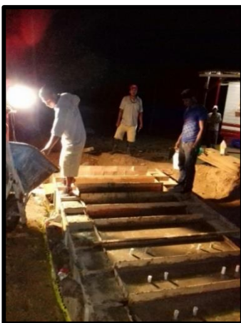
Fundición de tapaderas
