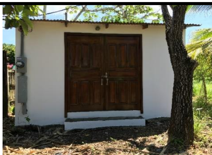
Reparación de puertas y aplicación de pintura en paredes externas de estación.
