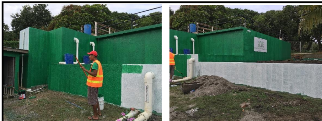
Aplicación de sellador y pintura
