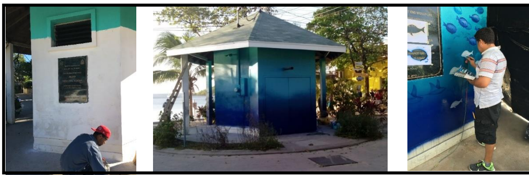
Trabajos de pintura
