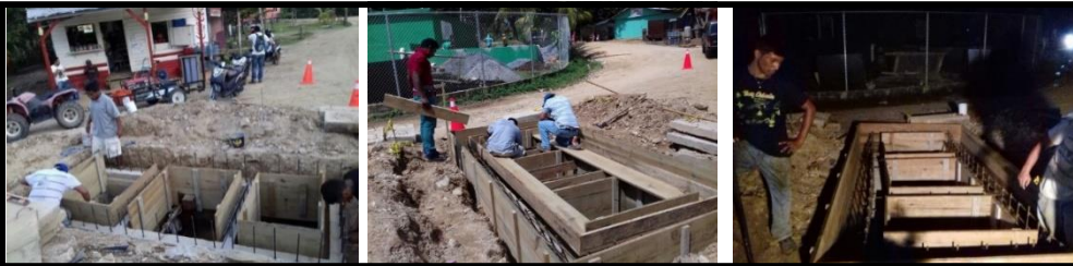
Encofrado y fundición de paredes de caja
