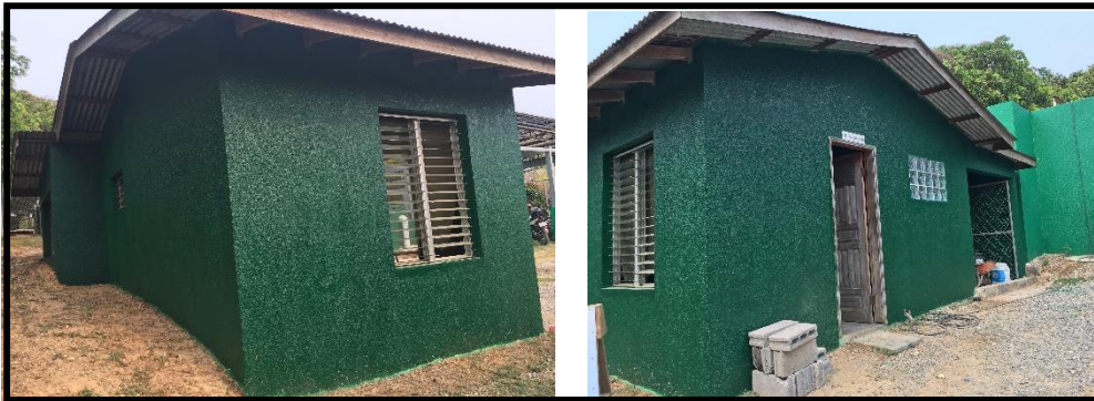
Trabajos de pintura finalizados
