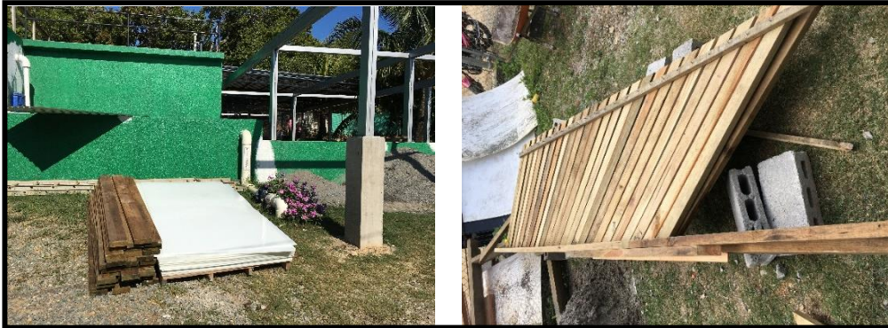
Láminas de polietileno y estructura nueva de madera
