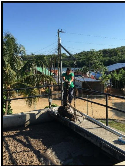
Uso de Estructura para extraer bomba
