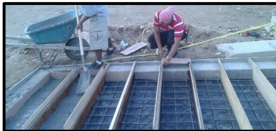
Preparación de área para fundición de tapaderas
