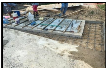
Fundición de área lateral a caja
