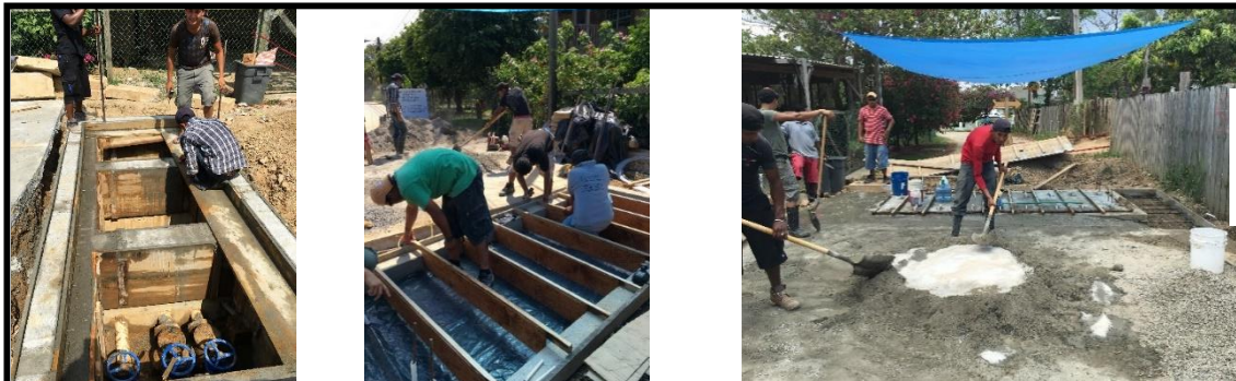
Preparación de área para fundición de tapaderas
